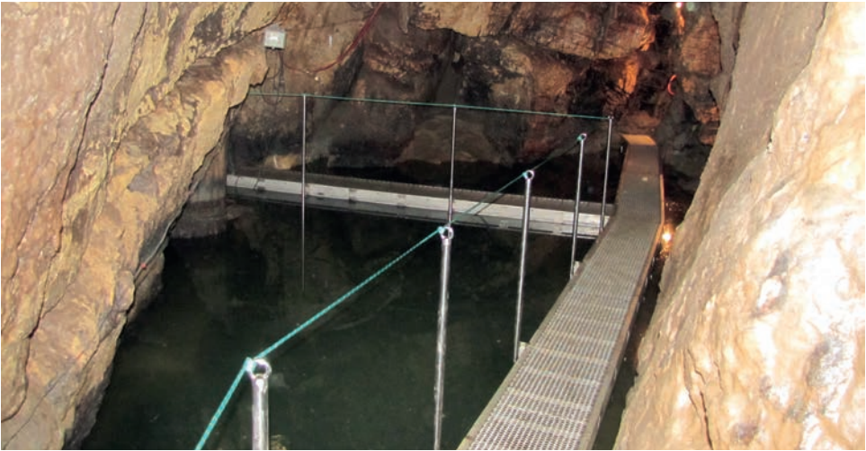
8. ábra: Beépített új járófelület
