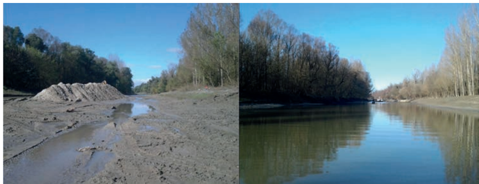
6. ábra: Senki-szigeti gázló a kivitelezés elején és végén
