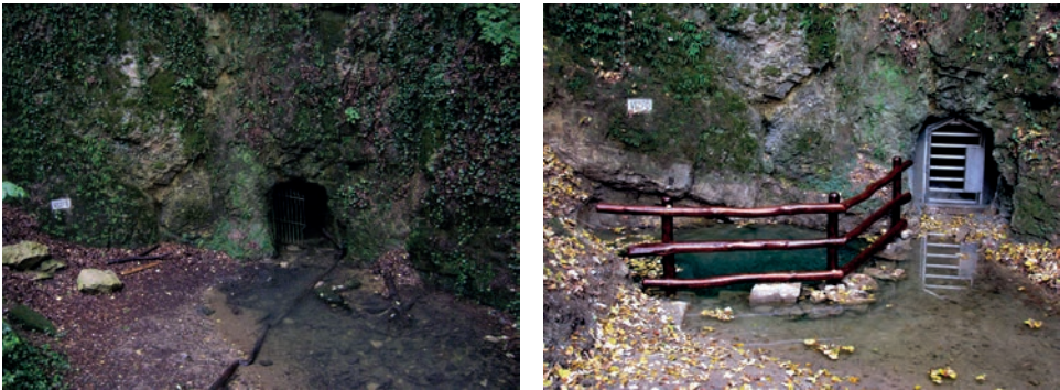
6. ábra: A barlang felújítás előtti bejárata (a), A barlang bejárata és a forrásszáj a munkák után (b)
