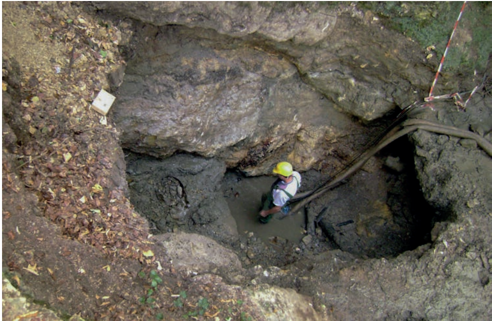
5. ábra: A forrásszáj kitisztítása
